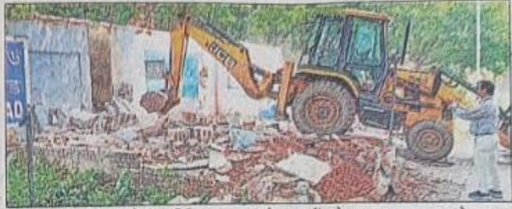
चितरजन के सिमजोरी में अतिक्रमण कर बने दुकानों को ध्वस्त करता बुलडोजर।
